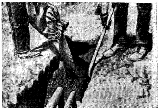
Рис. 9-15. Засыпка труб в траншее порошкообразным асфальтоизолом.
